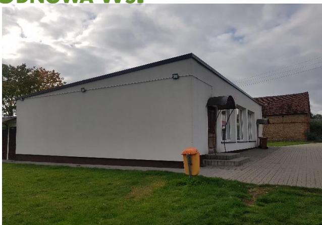
Zdjęcie 6 Budynek świetlicy wiejskiej
