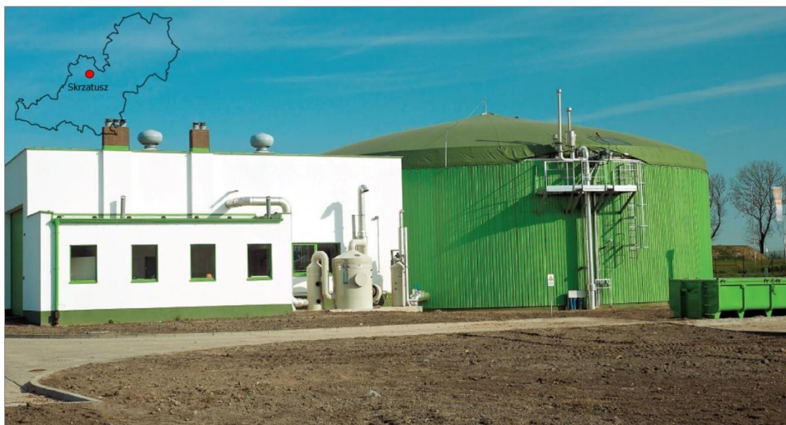
Rysunek 9 Elektrociepłownia biogazowa w Skrzatuszu.
