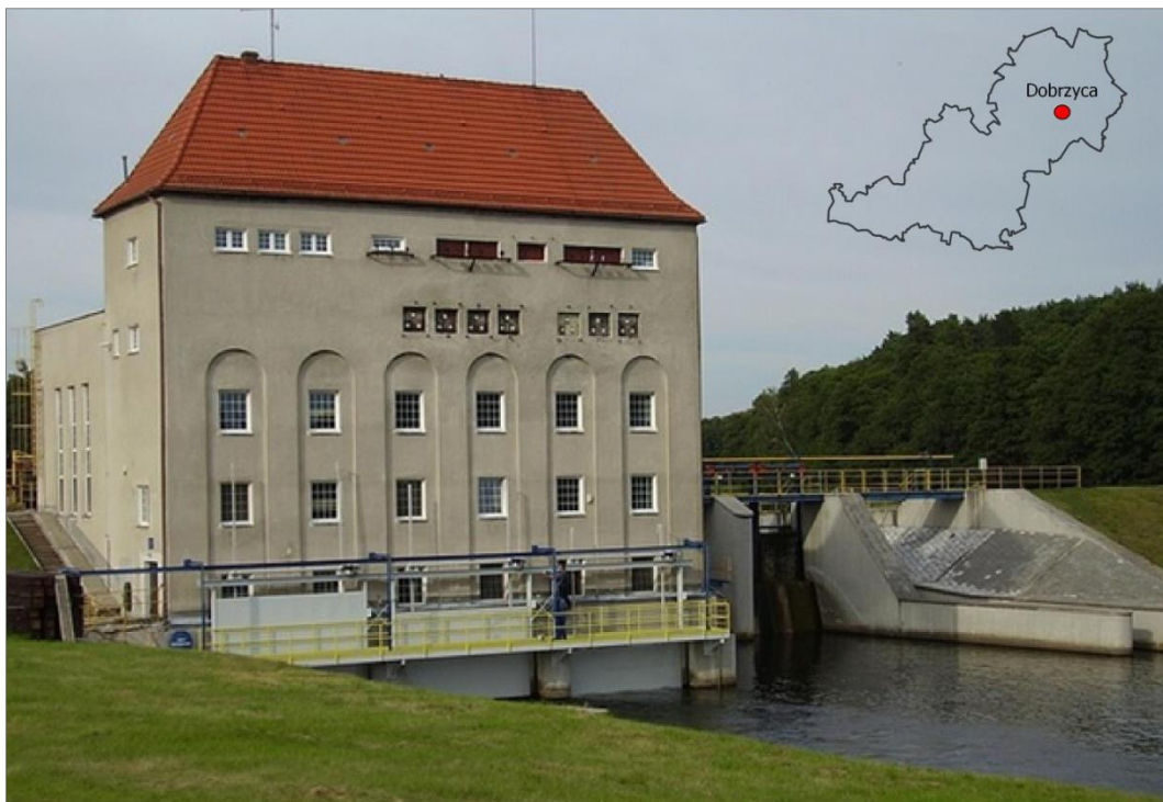
Rysunek 10 Elektrownia wodna w Dobrzycy.
